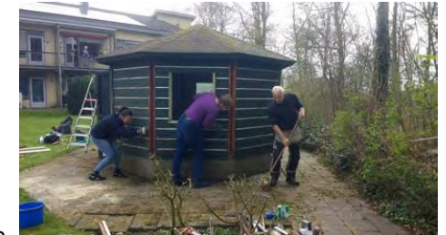
Bankje plaatsen, waar bewoners van een zorgcomplex even rustig kunnen zitten.
